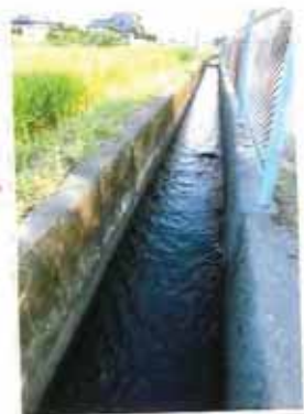
コンクリートの水路→
