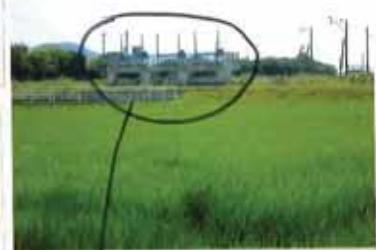
水門。水門の向うには海がある。
